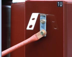
Клеммы выводов низкого напряжения
